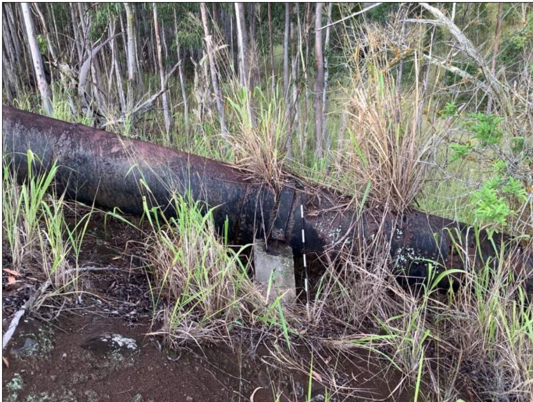
Figure 78. Site 7346 Feature 160-A siphon invert.
