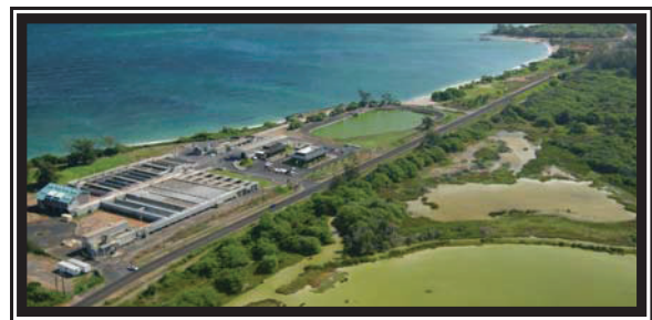
Kahului Wastewater Plant, Kahului, Maui, Hawai'i.
