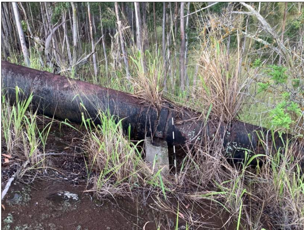
Figure 78. Site 7346 Feature 160-A siphon invert.
