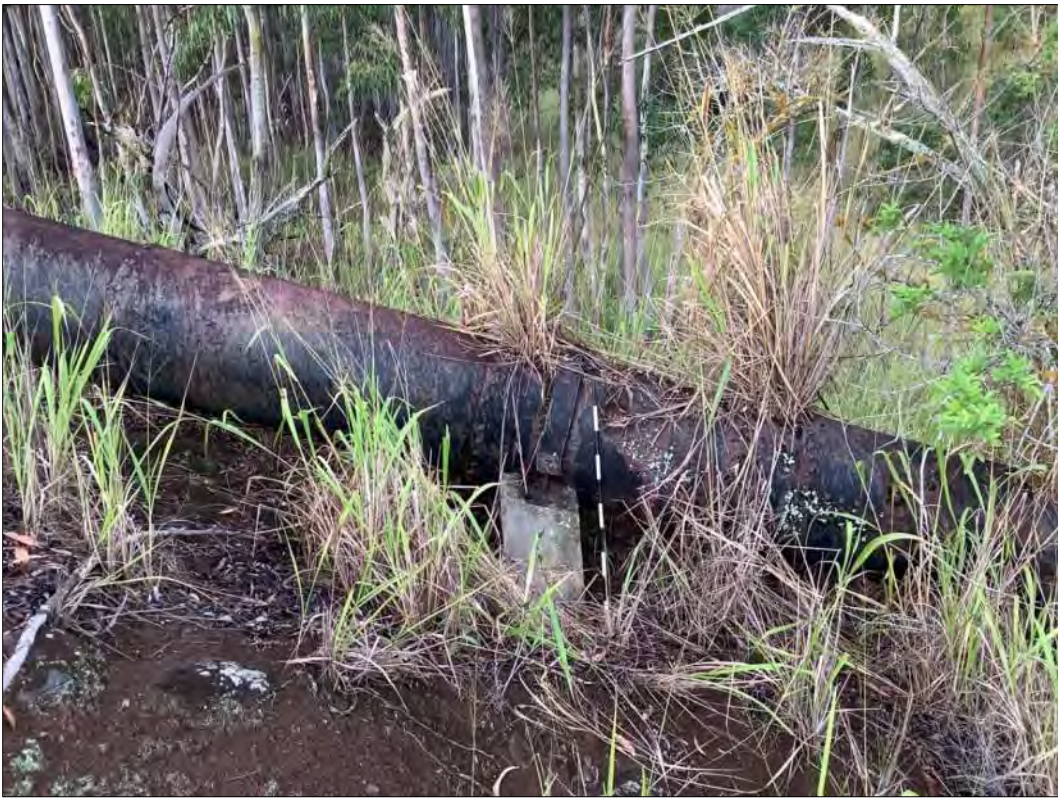
Figure 78. Site 7346 Feature 160-A siphon invert.
